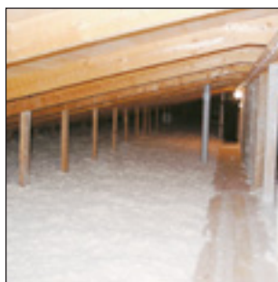
Efter tilläggsisolering med träfiber. Klart!
